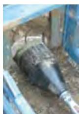
Uusi putki asettuu tiukasti vanhan putken seinämään
