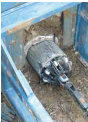
Ohjausrullilla varustettu rulla-avennin tasoittaa kaikki epämuodostumat
