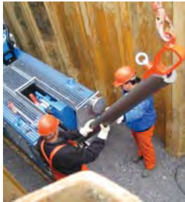
Työntötangon pikalukitus nostolaitteen avulla
