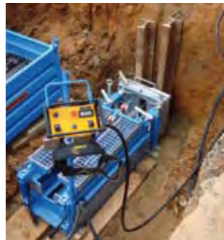
GRUNDOBURST-Lafette 400G Käyttö hydraulikkayksiköillä TT B20 tai TT B110
