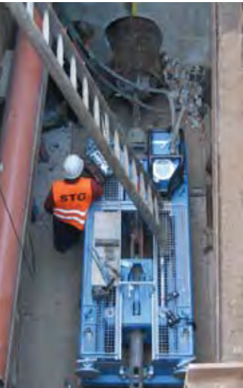
Työntötangon pikalukitus nostolaitteen avulla
