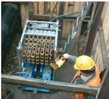
GRUNDOBURST 800G käyttövoimana hydrauliikkayksikkö TT B110
