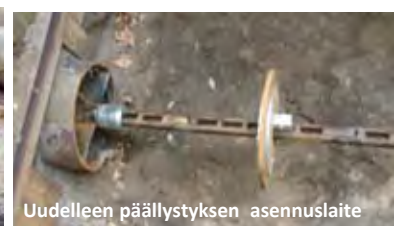
Uudelleen päällystys (putken vetäminen vanhan putken sisään)
