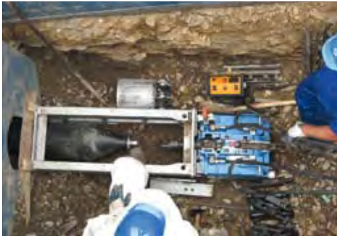
Ahtaissa työolosuhteissa GRUNDOBURST 400 S voidaan käyttää pienessä huoltotilassa.
