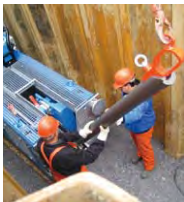
Työntötangon pikalukitus nostolaitteen avulla
