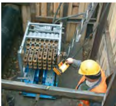
GRUNDOBURST 800G käyttövoimana hydrauliikkaysikkö TT B110
