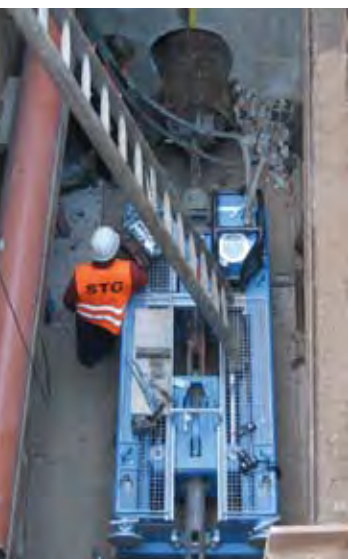
Työntötangon pikalukitus nostolaitteen avulla
